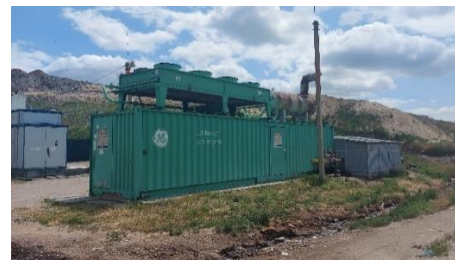
Фото. Когенераційна установка
