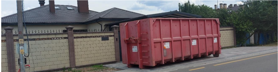
Фото. Контейнер 15 м 3 для збирання ремонтних відходів
